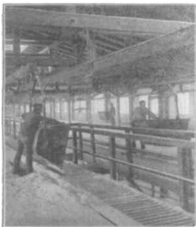
Abb. 6. Abstürzen von Fördergut auf Haufenlager durch Roste im Dachgeschoß eines Magazins vermittels einer Bleichertschen Handhängebahn.
