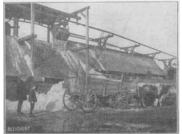
Abb. 14. Verladung von Rückständen auf Lager und in Fuhrwerke mittels einer Drahtseilbahn.
